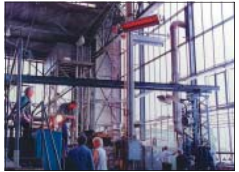
Obr. 3 Vytápění pracoviště u pece a venkovní stěny ve sklárně
